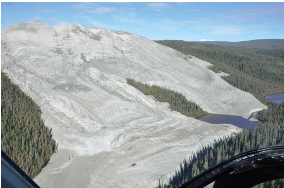
Ci-dessus : la pile de résidus miniers d'amiante effondrée et le ruisseau Wolverine.
